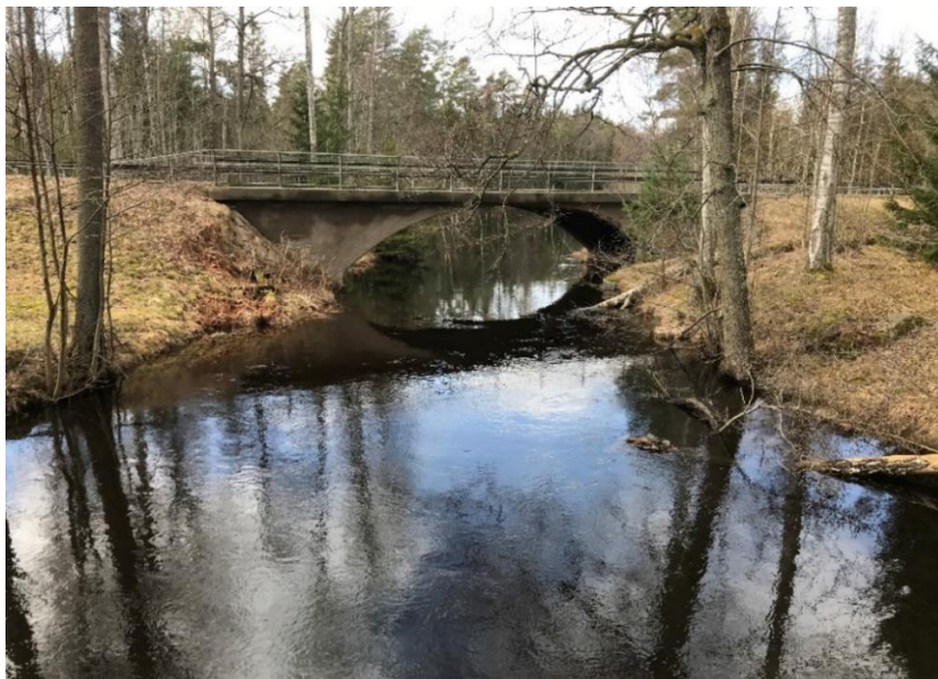
Figur 4. Betongbron (väg 860). Bilden är tagen i riktning mot strömmen.
