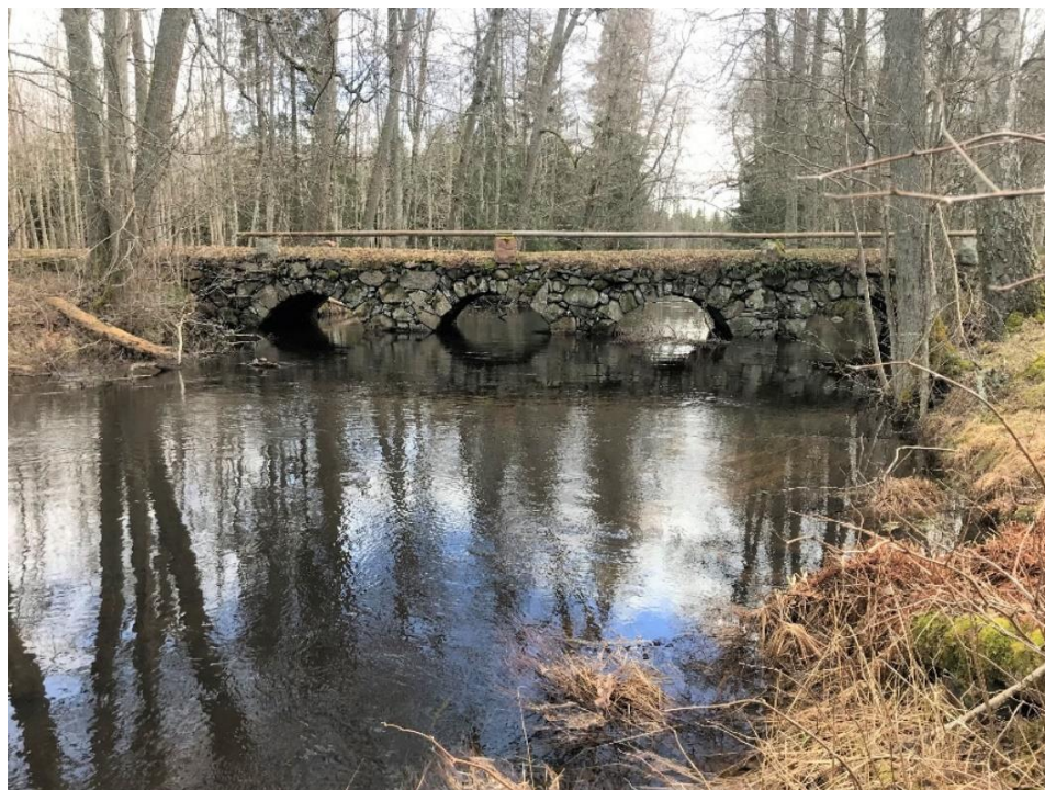
Figur 5. Stenvalvsbron (Gäddeforsabron) med 4 valvbågar. Bilden är tagen i strömriktningen.
