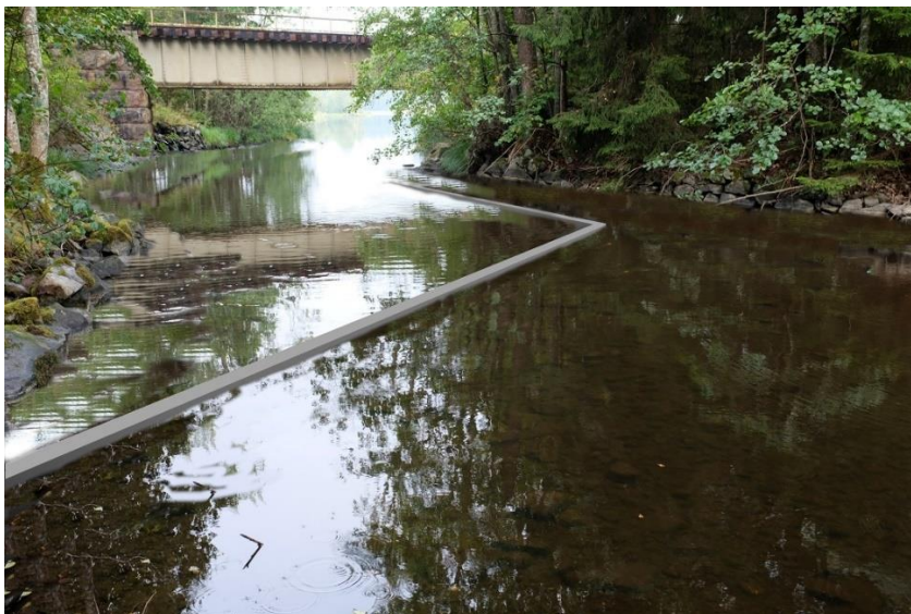
Figur 16. En visualisering av hur ett s.k. flödesutjämnande utskov i Nömmens utlopp skulle kunna se ut.
