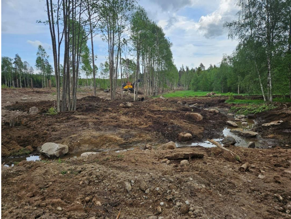
Figur 10. Brostugubäcken grävs om under 2024, från ett rakt dike till en slingrande bäck.
