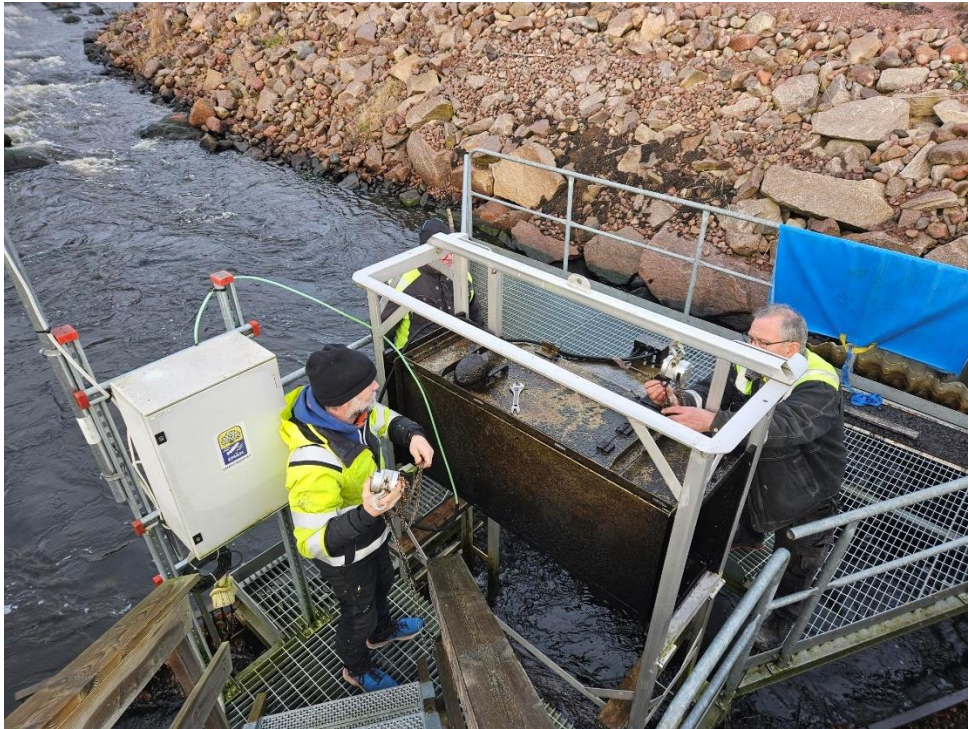
Figur 18. I slutet av november monterades så fiskräknaren ner efter 4 års uppföljning av fiskvandring upp- och nedströms i Karlshammar kraftverk.
